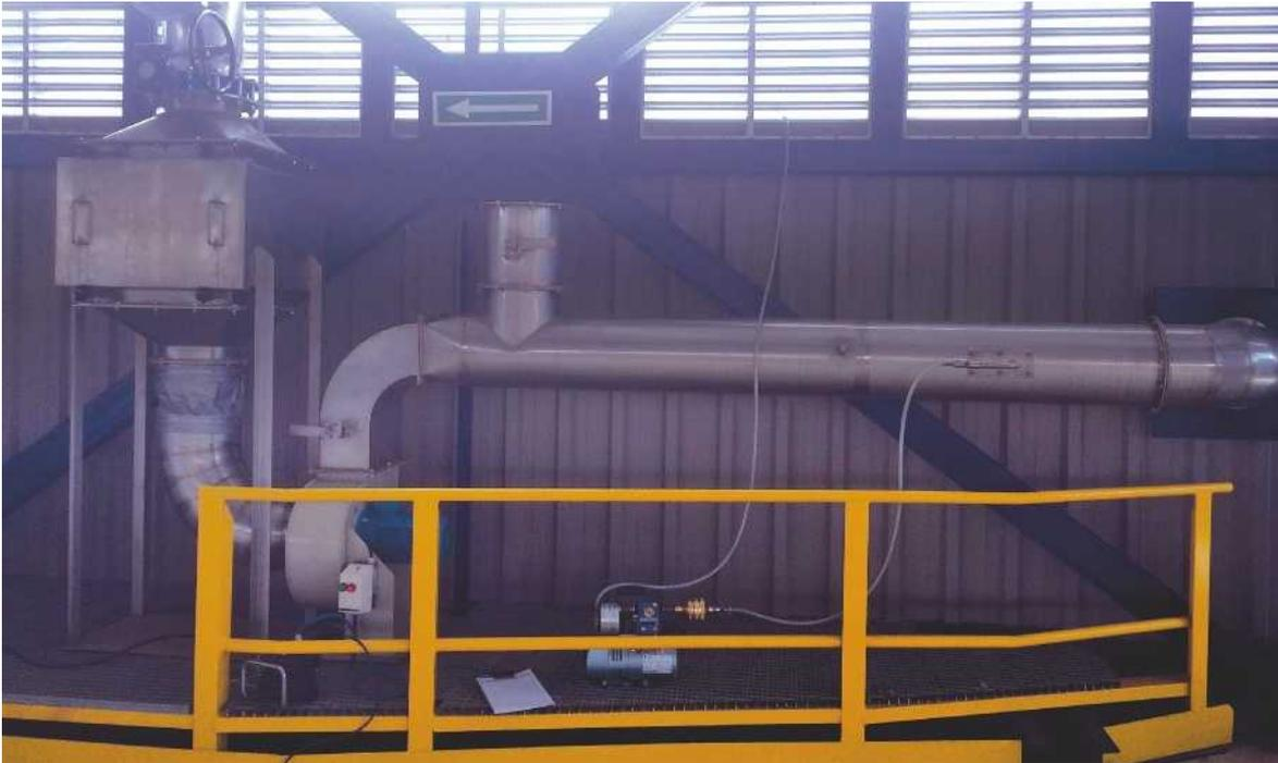
Sistema de extracción de gases.
