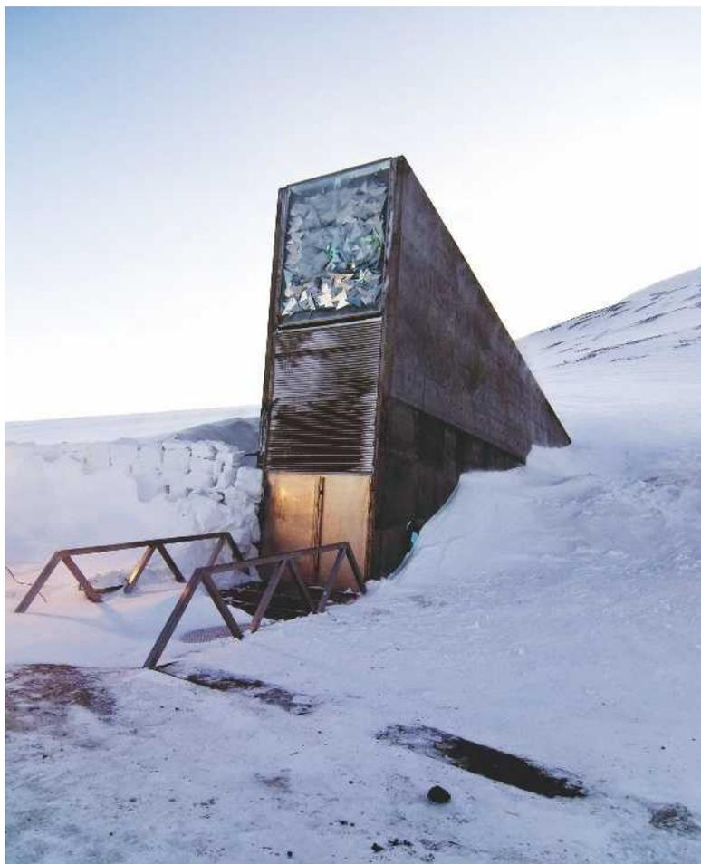
La Bóveda Global de Semillas ocupa lo que antiguamente fue una mina excavada a 130 metros de profundidad. Un bloque de hormigón sobre una montaña siempre nevada da acceso a las instalaciones.
