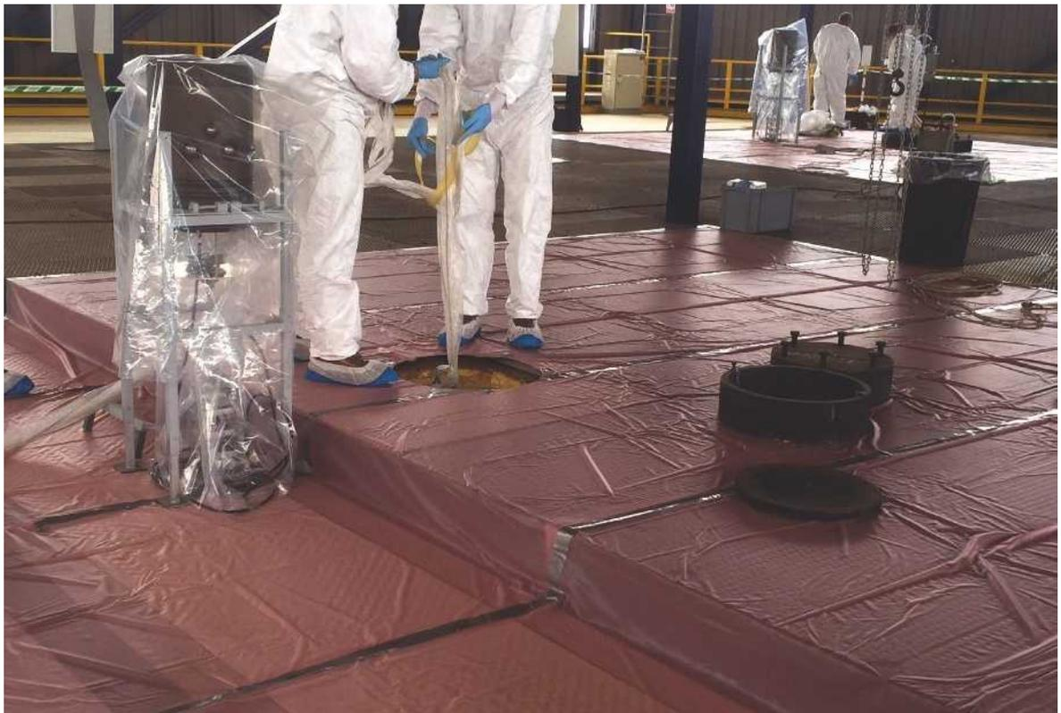
Introducción de la instrumentación en el cajón del reactor.
